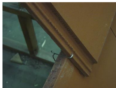
Photo 1 : Crochet d'ancrage E-clips type 2 pour la tuile en béton CREATON KAPSTADT
