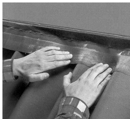
Foto 3: Aandrukken van de ondervorst op de betondakpannen
