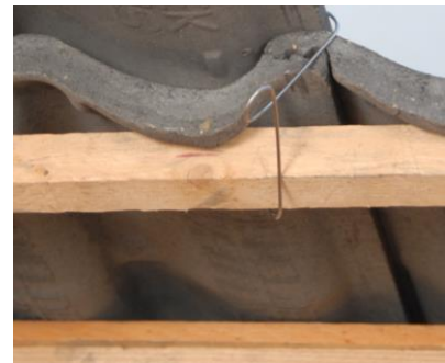
Photo 1 : Crochet d'ancrage X-tile pour tuile en béton ondulée (uniquement pour la Belgique)
