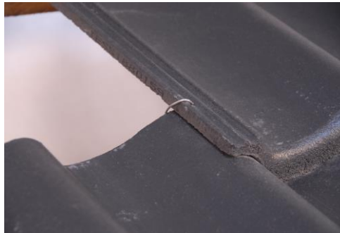
Photo 1 : Crochet d'ancrage X-tile pour tuile en béton ondulée (uniquement pour la Belgique)
