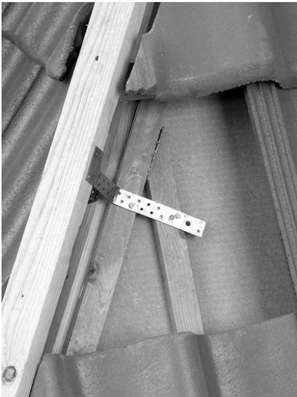
Photo 3 : Pose de support de latte sur l'arête
