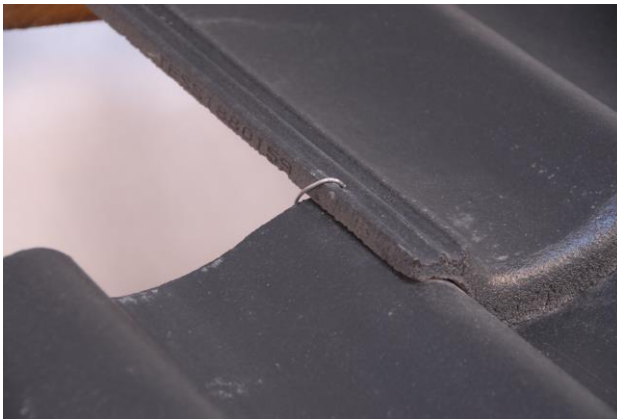
Foto 1: X-tile panhaak betondakpan (enkel in België)
